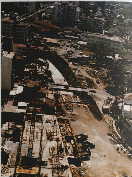
Fig. 67 Línea 1 del Metro de Santiago y, sobre ella, avenida Nueva Providencia en construcción a la altura de calle Suecia. P. Bannen, F. Chateau. La ciudad de Providencia en la obra de Germán Bannen. Santiago: Ediciones ARQ, 2007.
