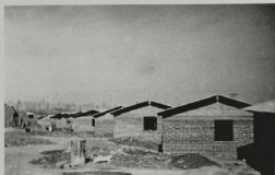
Fig. 169 Fernando Castillo Velasco et al., Villa La Reina en construcción. Alvarado Jorge, "Auto Construcción Villa La Reina". Tesis (Constructor Civil), Santiago, Chile, Pontificia Universidad Católica de Chile, Escuela de Construcción Civil, 1967, p. 36.
