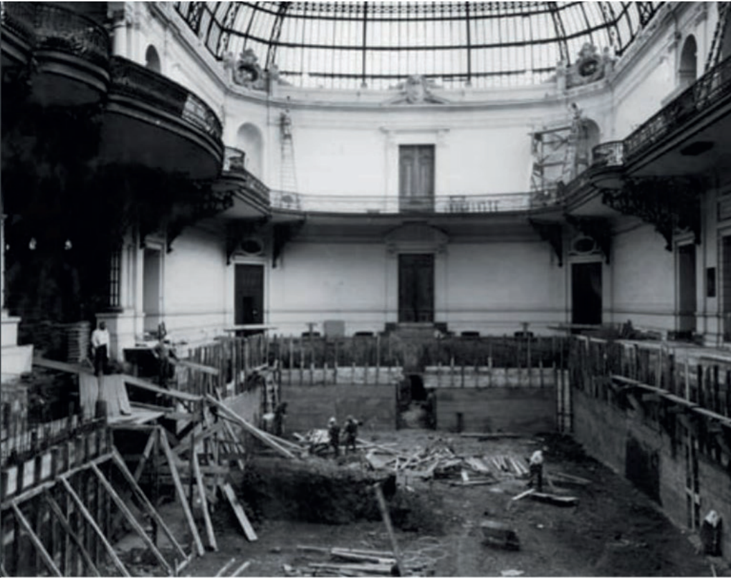
Figura 5. Construcción Sala Matta 1970
