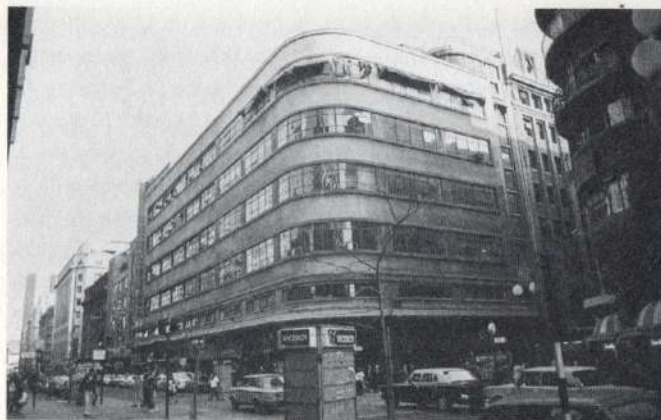
Fig.1: Sergio Larraín, Jorge Arteaga. Edificio Oberpauer / Oberpauer Building . Santiago, Chile, 1930. © Archivo de Originales. FADEU. Pontificia Universidad Católica de Chile.
